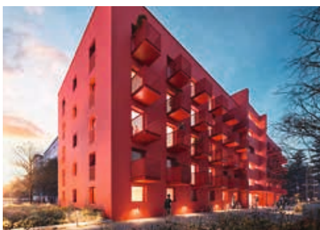
Im ehemaligen Wohnheim in Niederrad sollen bis Ende 2020 137 Appartements entstehen.
