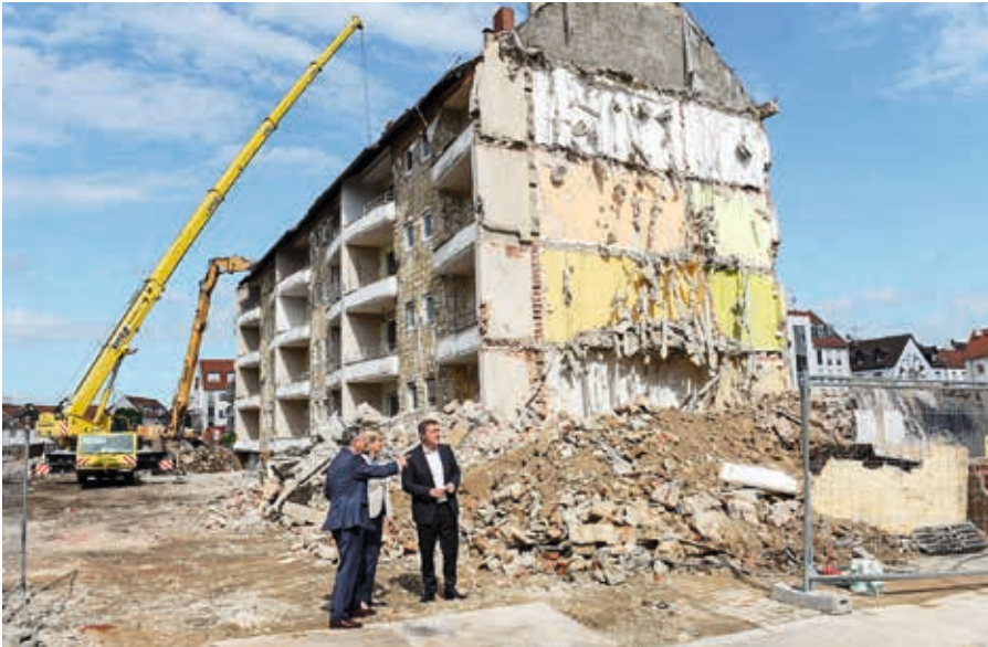
Abriss von Wohngebäuden aus den 1950er Jahren in Hanau: Hier entstehen 156 Wohnungen, 30 davon gefördert, mit 10.500 Quadratmetern Wohnfläche.
