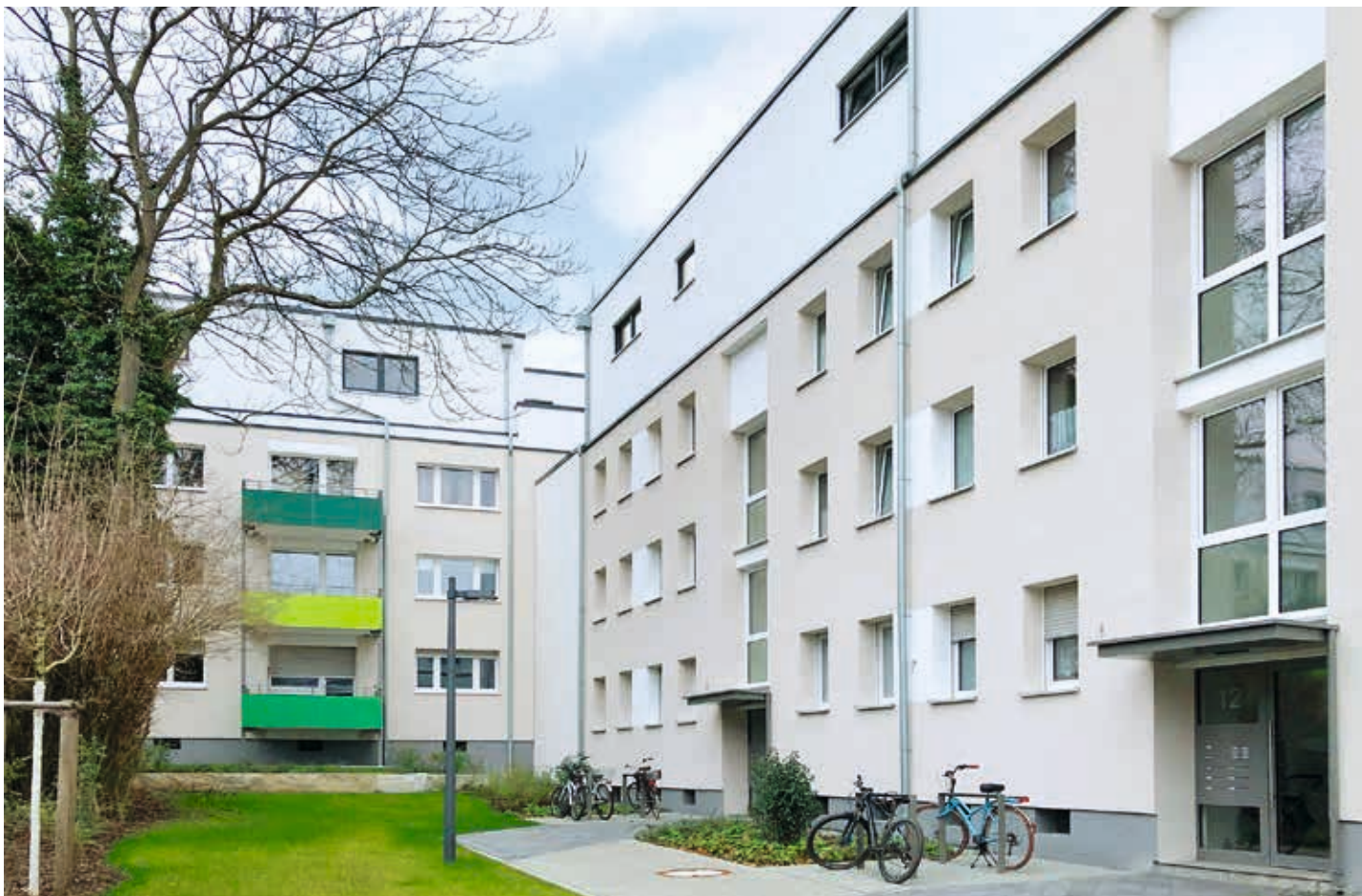
Mehr Wohnraum ohne Flächenverbrauch: In Darmstadt-Bessungen wurden sieben Wohnungen auf Bestandsgebäude aufgesetzt – inklusive Smart-Home-Technologie.
